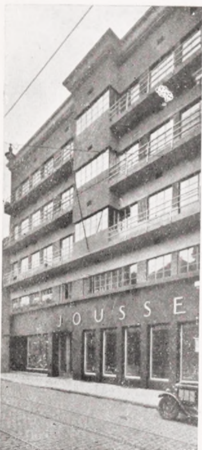
Fig. 256. Immeuble à Gand.
